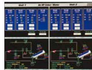
Painel de monitoramento e controle avançado do Coker Mister
