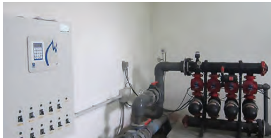
Unité de contrôle de l'irrigation, pour la programmation du temps d'irrigation et du débit
