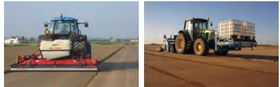
Una vista de la superficie del suelo después de la pasada de un rodillo compactador
