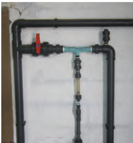
Cuando no hay bomba de inyección disponible, el producto se puede incorporar al agua mediante la succión por un sistema Venturi
