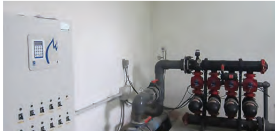
Κεντρική μονάδα ελέγχου για τον προγραμματισμό του χρόνου και της ροής άρδευσης
