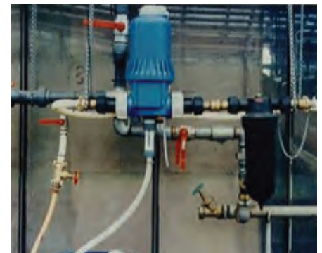
Η αντλία για την έγχυση του metam από τη δεξαμενή στον σωλήνα νερού της άρδευσης λειτουργεί με ηλεκτρισμό.
