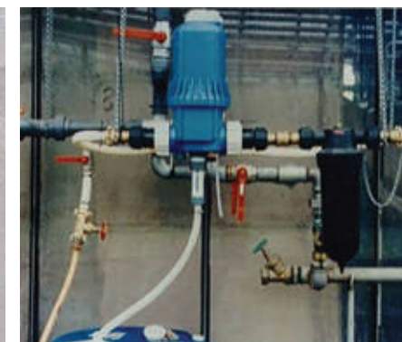
Une méthode plus courante consiste à connecter une pompe doseuse directement au fût de metam
