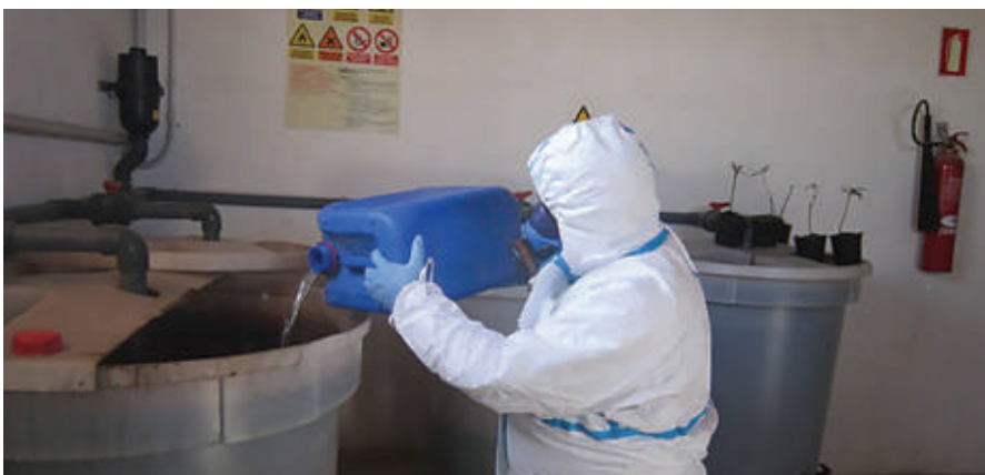
Το metam εισάγεται στην κεφαλή του συστήματος άρδευσης, ρίχνοντας το προϊόν μέσα στη δεξαμενή (όχι ιδιαίτερα κοινή μέθοδος)
