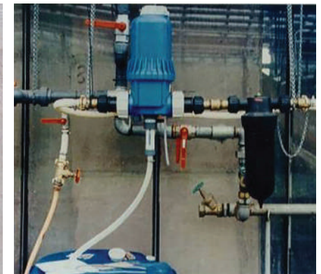
In alternativa, una pompa può essere collegata direttamente al serbatoio contenente metam (soluzione più praticata)
