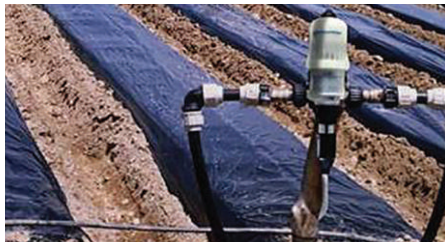
Irrigação externa por gotejamento
