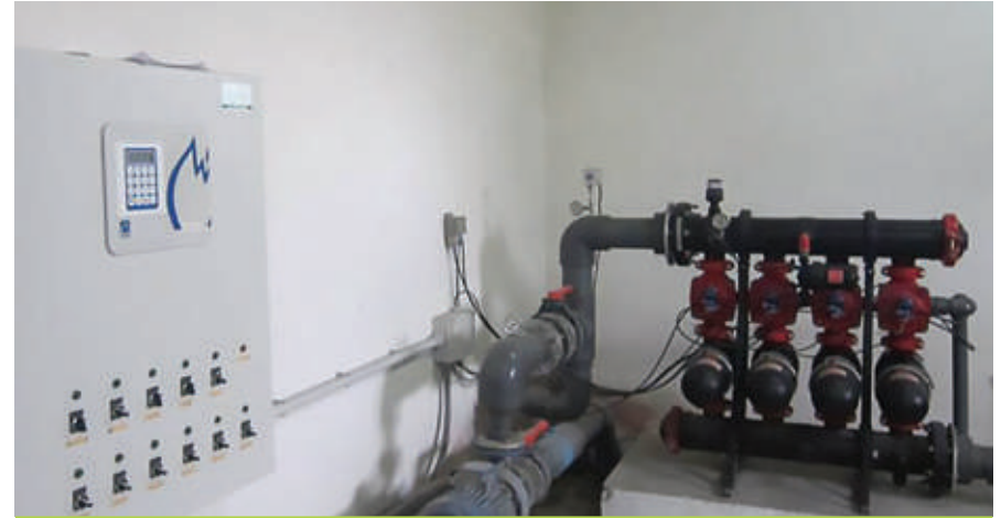
La unidad de control central debe programar el tiempo y caudal de riego
