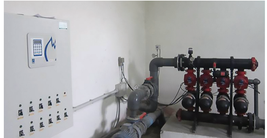
Unità di controllo centrale per programmare il tempo e il flusso di irrigazione
