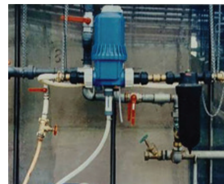
Η αντλία για την έγχυση του metam από τη δεξαμενή στον σωλήνα νερού της άρδευσης λειτουργεί με ηλεκτρισμό.
