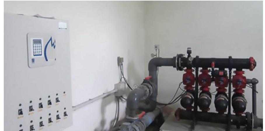
Unité de contrôle de l'irrigation, pour la programmation du temps d'irrigation et du débit
