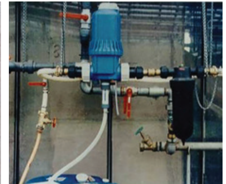
Une méthode plus courante consiste à connecter une pompe doseuse directement au fût de metam
