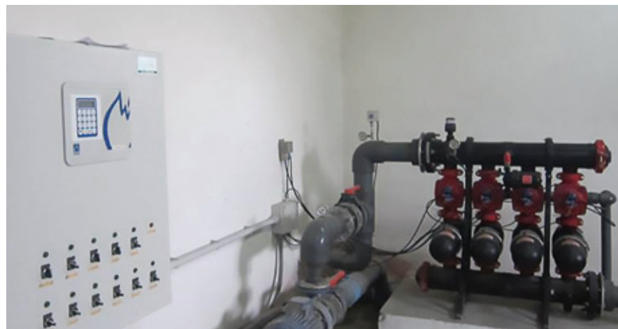
Unidade de controle central para programar o tempo e fluxo de irrigação
