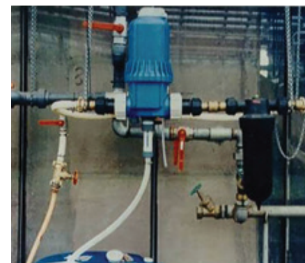
Alternativamente, uma bomba pode ser conectada diretamente ao tambor contendo metam (método mais comum)
