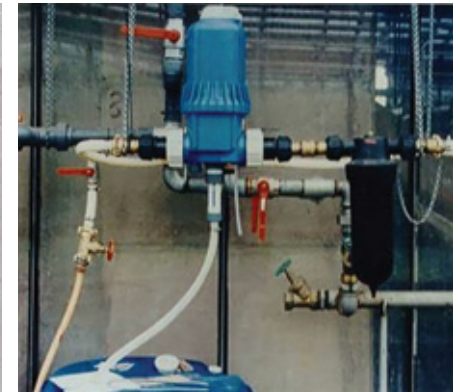
Por otra parte, la bomba se puede conectar directamente al tambor que contiene metam (metodo mas común)
